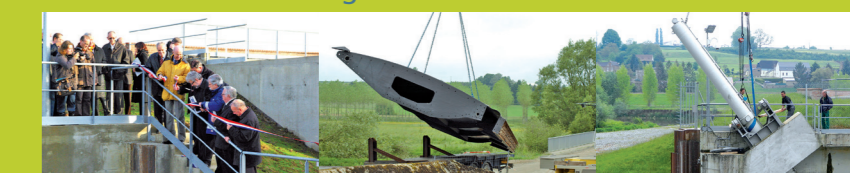
Inauguration du site de Proisy - novembre 2009 | Pose du clapet, constitué de deux volets assemblés sur place | Pose d'un verin à l'automne 2009
